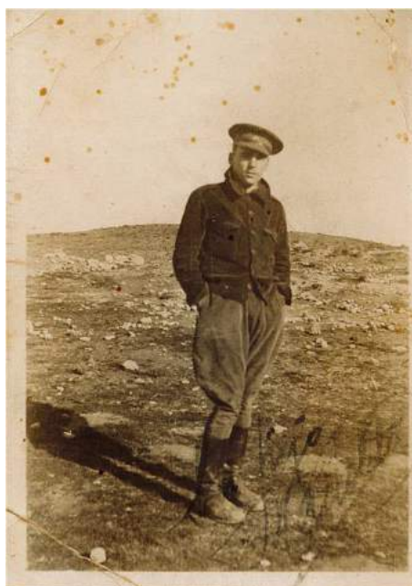
Ilustración 21. Marcas de deterioro. Fotografía nº2. Fuente: Familia Llobregat Serra.
