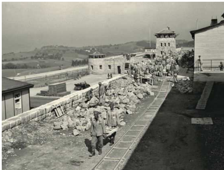
Ilustración 3. Construcción de un muro en Mauthausen a comienzos de 1941.
